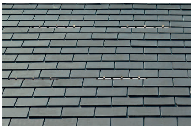
Illustration 5 : Configuration finale de la structure avec 4 capteurs
